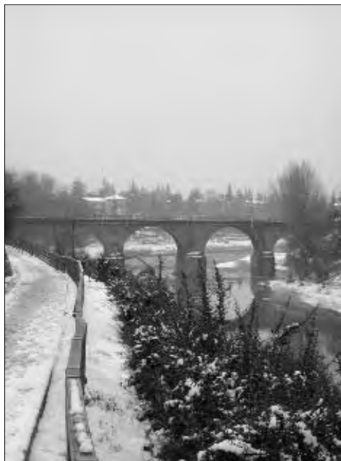
Foto 2 – Il ponte sul fiume Reno
